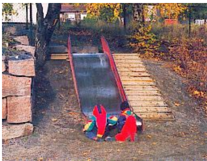
Over: Sklien er bygget inn i terrenget og gir dermed flere adkomstmuligheter
